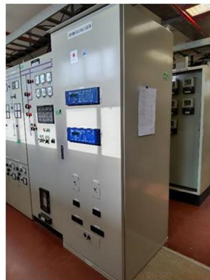
先行事業にてカンパラ市内のルゴゴ変電所に導入した機材 (左、中央：フォルトレコーダ 右：フォルトロケータ)
