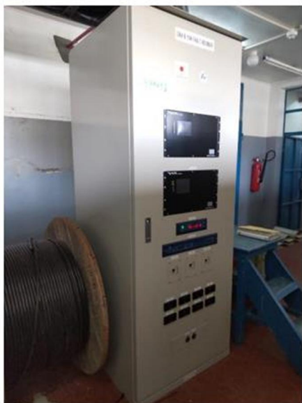
先行事業にてカンパラ市内のルゴゴ変電所に導入した機材 (左、中央：フォルトレコーダ 右：フォルトロケータ)
