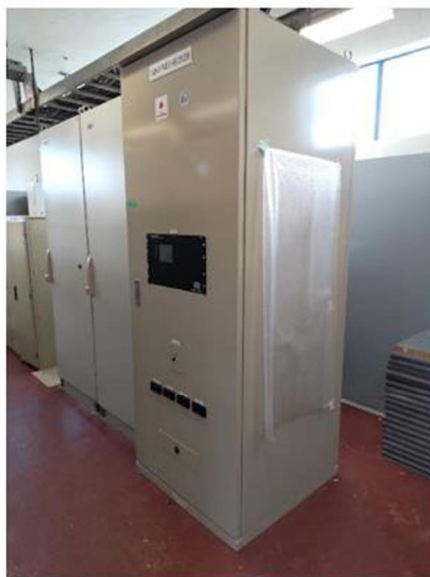
先行事業にてカンパラ市内のルゴゴ変電所に導入した機材 (左、中央：フォルトレコーダ 右：フォルトロケータ)
