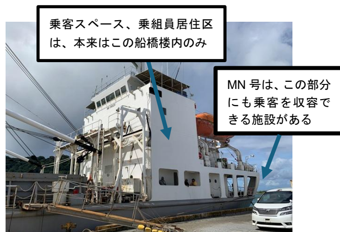
CV号の乗客収容施設（コンサルタント撮影）
