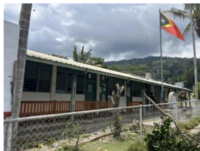
事業対象地域のヘルスセンター
