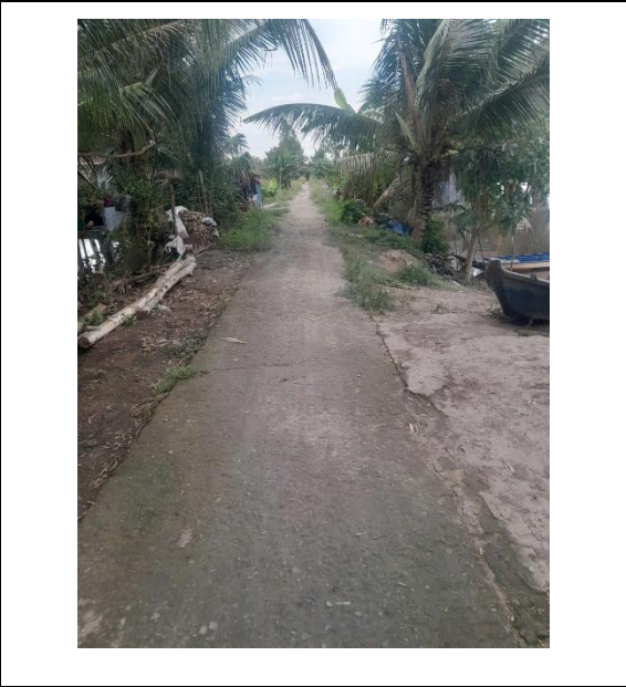
整備された道路（ホアビンコミュニティ）
