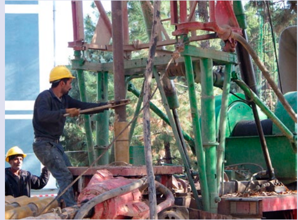
第2デモサイト (マチトン) での井戸掘削工事 (写真: 日本地下水開発株式会社)
