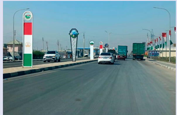
工事終了後の道路。歩道や柵、中央分離帯、夜間照明が設置され交通の安全性が確保された。（写真：JICA）
