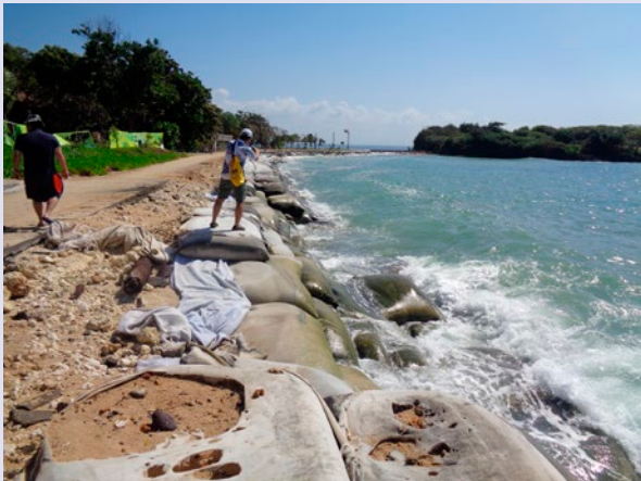
事業実施前、護岸の損傷・崩壊が目立つヌサドゥア海岸（写真：日本工営株式会社）
