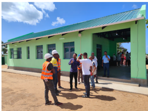
モザンビークでサイクロンにより被災した保健施設の修繕が完了し、最終検査を行うピースウィンズ・ジャパンのスタッフ、州保健局職員および建設会社（JPFを通じた日本の緊急人道支援）（写真：ピースウィンズ・ジャパン）
