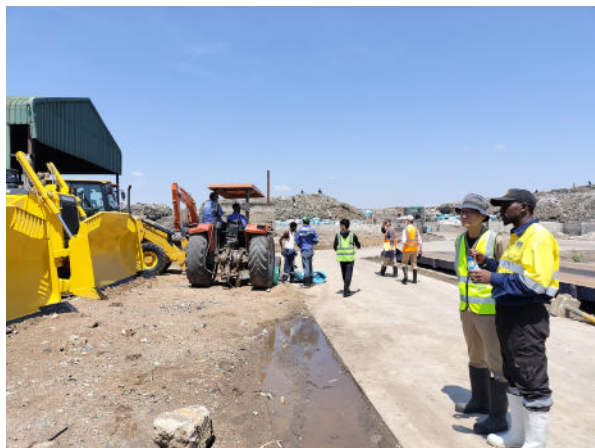
「ルサカ市きれいな街プロジェクト」の一環として、ザンビアの首都ルサカの廃棄物最終処分場において、ザンビアの関係者と共に重機の維持管理に取り組むJICA専門家（写真：JICA）
