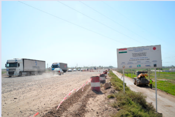
工事中の道路。道路は舗装されておらず、歩道も設置されていなかった。(写真：JICA)
