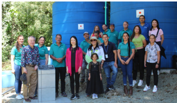
草の根・人間の安全保障無償資金協力により、コスタリカの農村地域で新たな水源を活用したポンプシステムおよび貯水タンクが整備された様子
