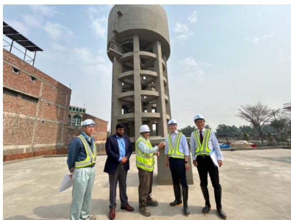
パキスタン第3の人口を擁するファイサラバードに対する「浄水場及び送配水管網改善計画」によって設置された配水施設
