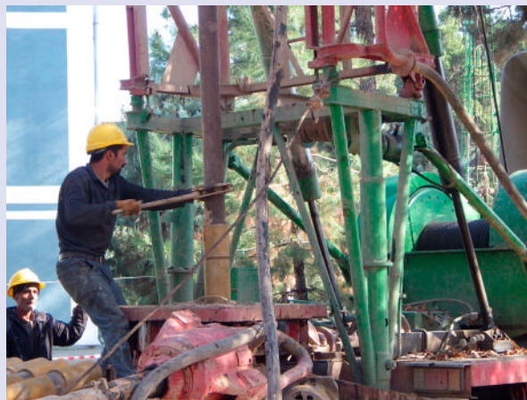
第2デモサイト (マチトン) での井戸掘削工事 (写真: 日本地下水開発株式会社)
