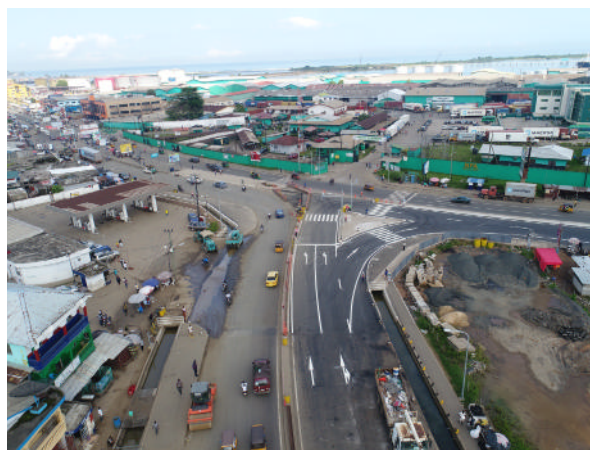
2013年以降、日本が建設・改修に携わっているリベリア国内の幹線道路「ジャパン・フリーウェイ」(写真: JICA)
