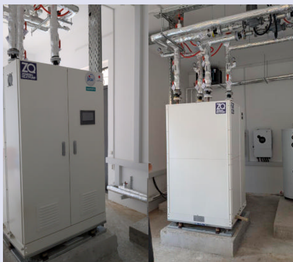
第1デモサイト (ドゥシャンベ市) に設置したGSHPシステム (写真: 秋田大学)
