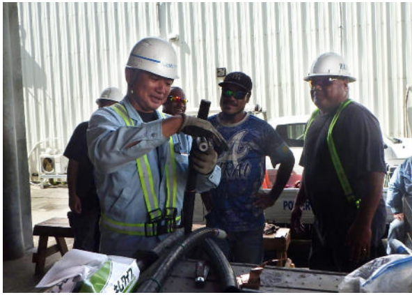
パラオに対する無償資金協力「送電網整備計画」において、公共事業公社職員に対して地中ケーブルの端末処理方法を指導する日本企業技術者（写真：株式会社トーエネック国際事業統括部）
