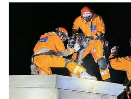
救助チームの総合訓練で被災者を救出するため進入口を確保する隊員
