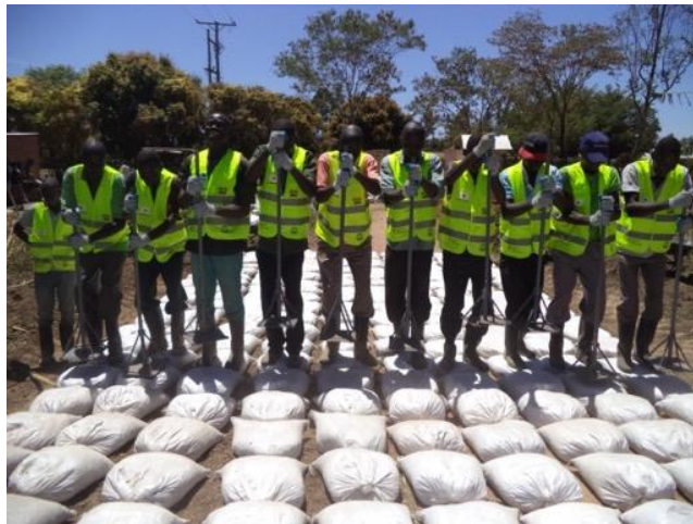
4) 土のう締めめ：最低2段設置
