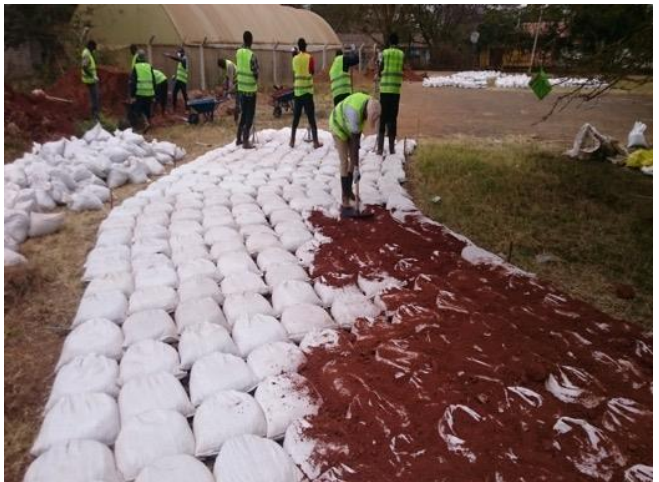
5) 土のうの隙間に礫質土を敷詰める
