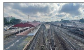
ナイロビ中央駅 信号・車軸検知装置の器具箱設置予定地 (3)
