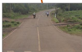
踏切設置予定地 (1)
