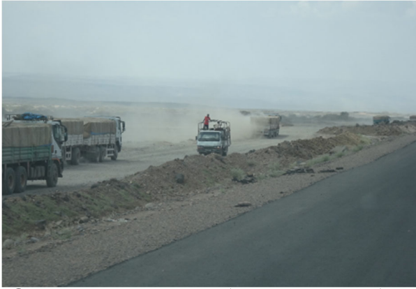
⑨ サウジ工区迂回路（手前舗装したて）
