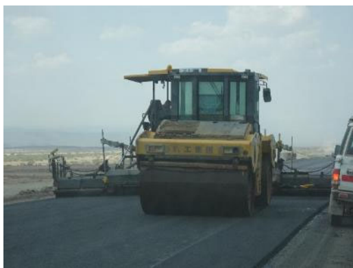
サウジ工区の中国企業による舗装工事
