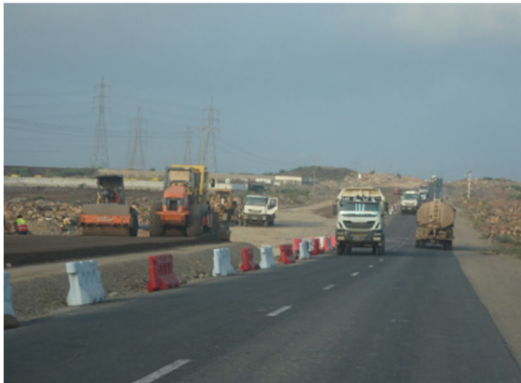
① ジブチ市→ディキル方面 (世銀拡幅工事中区間)
