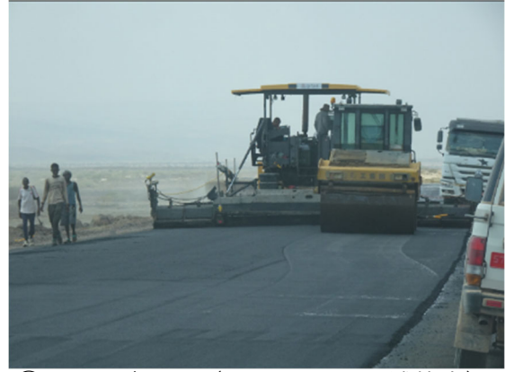
⑩ サウジ工区（アスファルト舗装中）
