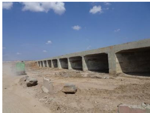
設計変更で追加された連結カルバート
