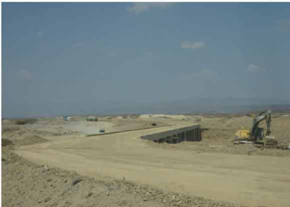
⑪ サウジ工区（拡大カルバート）
