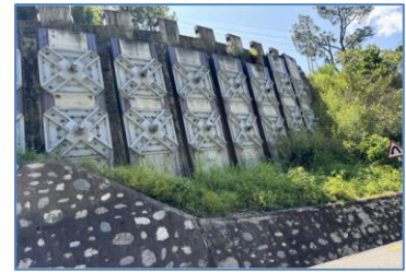
2015 年の大地震後、道路斜面对策を行ったシンズリ道路震災復旧計画 （評価チーム撮影）
