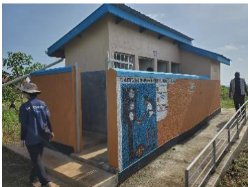
本案件で新設された男子生徒用トイレ。
