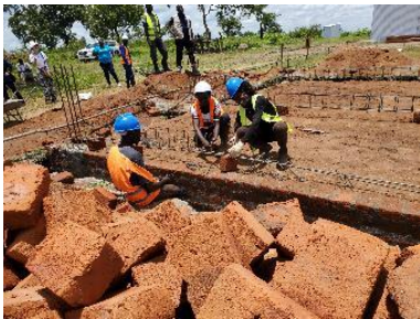
本案件でPWJの職業訓練を受けた修了生2名が、ILOのコースセンターの建設現場にて、男性職員に交じって建設作業員として勤務していた。
