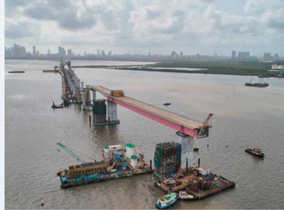
海上での鋼床版箱桁（OSD）架設作業（写真：MMRDA/L&T-IHI Consortium）
