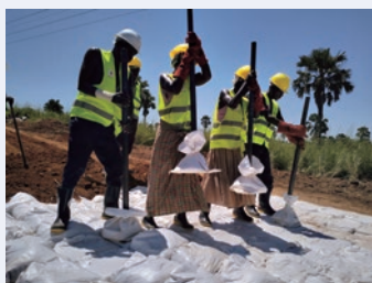
土のう工法を用いた農道補修訓練（写真：特定非営利活動法人道普請人）
