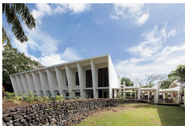
サモアにおいて日本が無償資金協力を通じて建設を支援した太平洋気候変動センター (写真: JICA)
