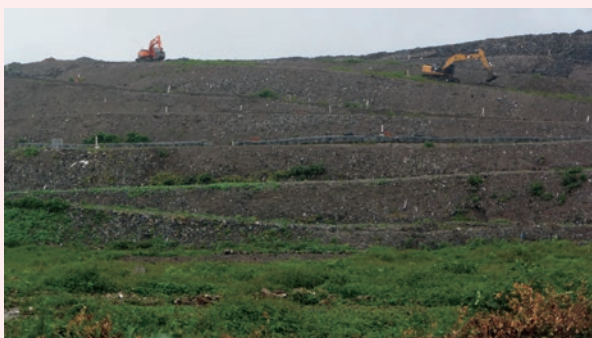
福岡方式によって改善されたアディスアベバ市のコシェ処分場（写真：UN-Habitat）
