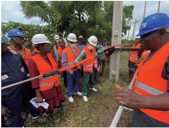
ナイジェリア「配電分野能力向上プロジェクト」で供与する機材（防護管）の設置作業を実演する様子（写真：Ruriko Suezawa）
