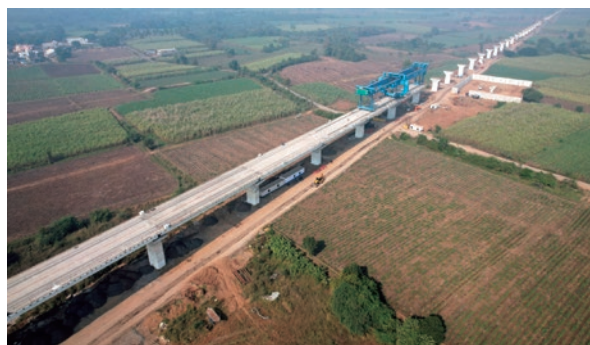
インドの「ムンバイ・アーメダバード間高速鉄道建設計画」におけるフルスパンキャストリング組立 (高架橋桁の一括製作の工法) の様子 (写真: インド高速鉄道公社 (NHSRCL))
