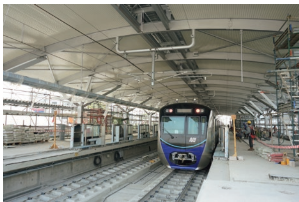
インドネシアに対する有償資金協力「ジャカルタ都市高速鉄道事業（フェーズ2）（第一期）」で建設中の駅舎と車両（写真：JICA）
