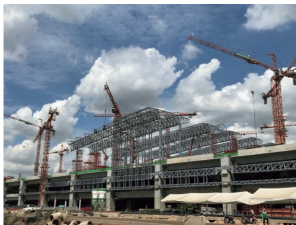
タイ「バンコク大量輸送網整備事業（レッドライン）(3)」において、屋根を建設中のバンスー（現クルンテープ・アピワット）駅（写真：JICA）
