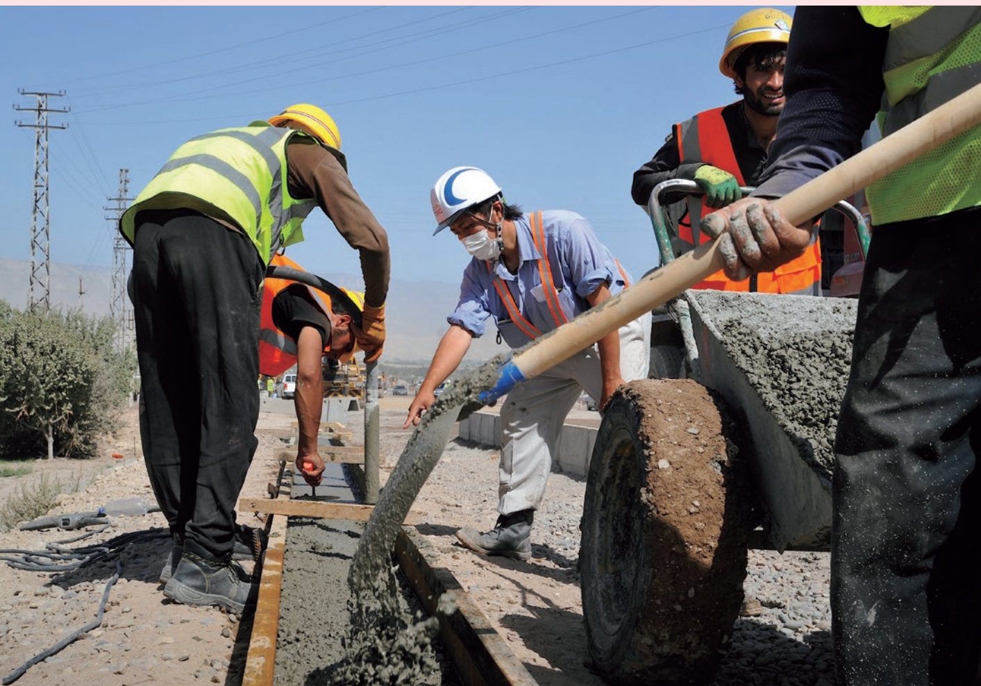
タジキスタンにおける無償資金協力「ドゥシャンベーボフタル道路におけるキジルカラーボフタル間道路改修計画」の施工現場で、現地作業員にコンクリート打設作業を指導する日本人技術者（写真：JICA）
