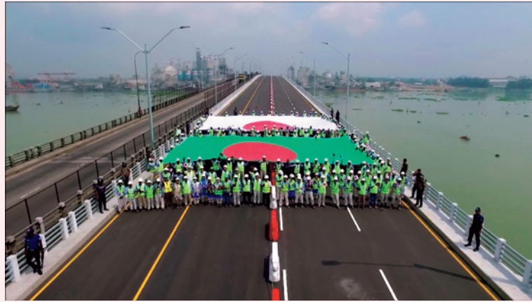
バングラデシュ 「カチプール・メグナ・グムティ第2橋建設及び既存橋改修事業」(円借款)
