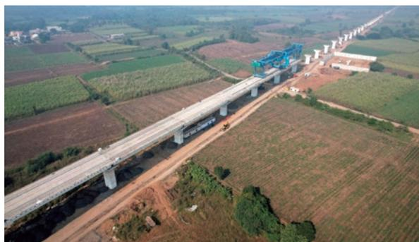
インドの「ムンバイ・アーメダバード間高速鉄道建設計画」におけるフルスパンキャストイング組立 (高架橋桁の一括製作の工法) の様子 (写真: インド高速鉄道公社 (NHSRCL))
