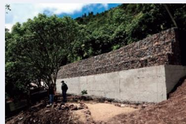
斜面災害対策管理プロジェクトを通じ整備された落石防護壁
