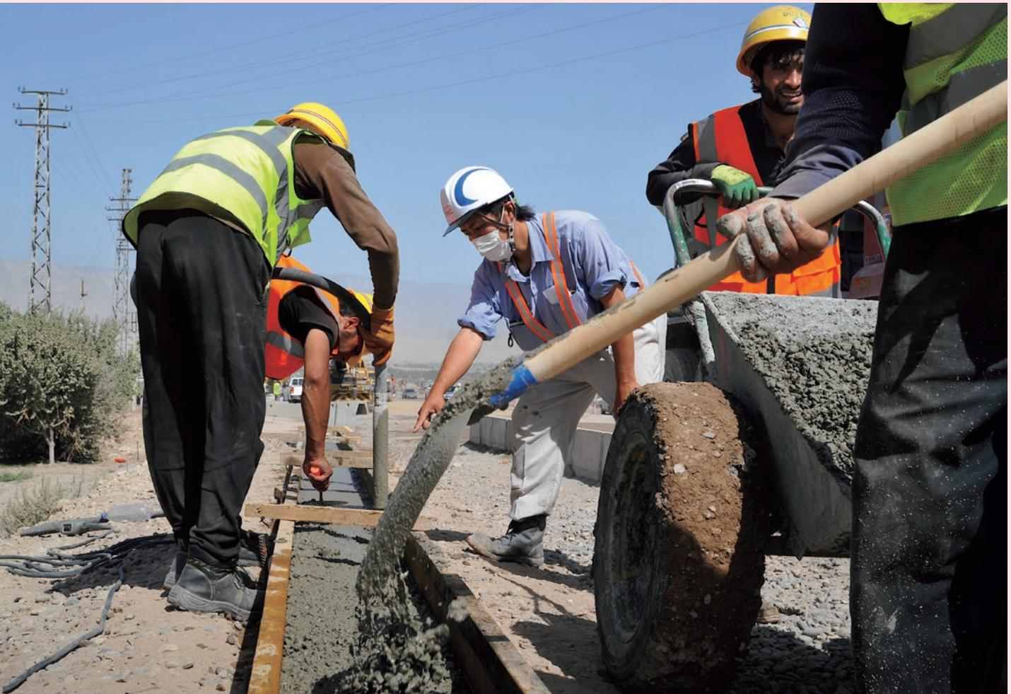
タジキスタンにおける無償資金協力「ドゥシャンベーポータル道路におけるキジルカラーポータル間道路改修計画」の施工現場で、現地作業員にコンクリート打設作業を指導する日本人技術者（写真：JICA）
