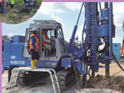
普及・実証事業では地盤改良機の操作や施工ノウハウなど、技術伝承や人材育成にも注力している。
