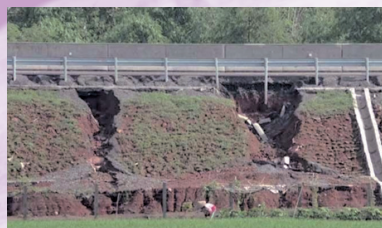
Pemalang - Batang 高速道路で発生した亀裂。弱い地盤に施工された盛土が、豪雨で浸食されたことで起こったと推定される。現地にはこのような事例がたくさんある。
