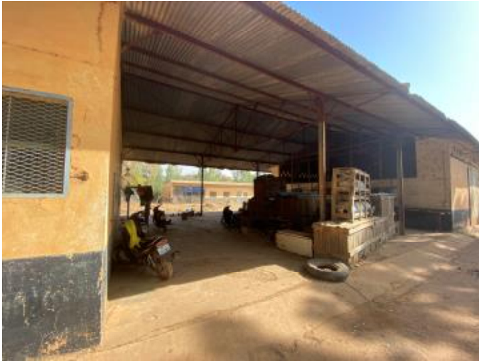
機材・交換部品等置き場
