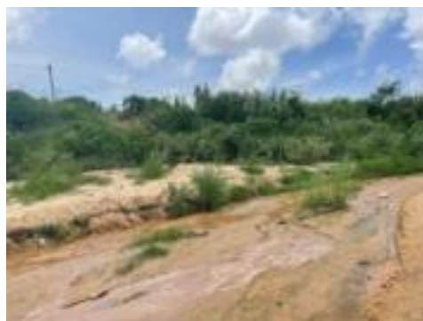
トリアングロ流域の浸食の様子（上流部）
