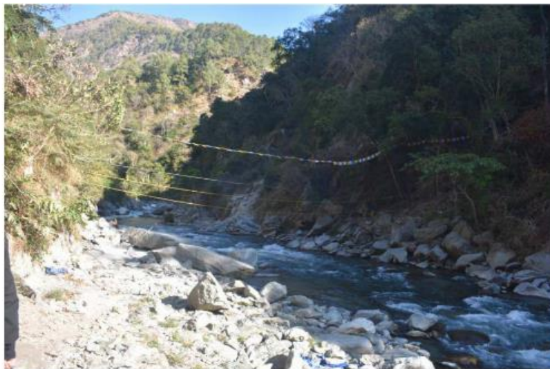
ジョモリ水力発電所ダム（調整池）サイト
