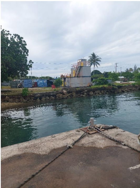
栈橋と護岸 出典：JICA
