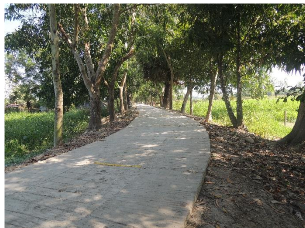
施工後の道路（エーヤワディー地域）
