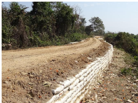
施工後の道路（カレン州）
