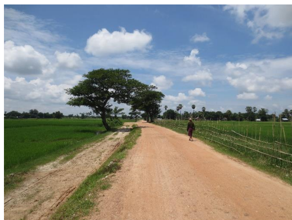
施工後の道路（ネピドー連邦領）
