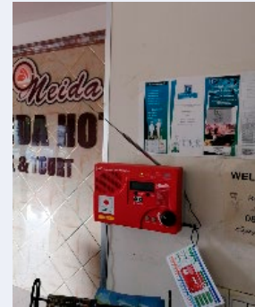
遠隔起動型受信機（RAR）。サイレン警報音到達範囲の拡大・補完を目的に、設置された「屋内用サイレン端末」で、全国約500か所に導入。（写真：八千代エンジニアリング株式会社・一般財団法人 海外通信・放送コンサルティング協力・国際航業株式会社共同企業体）
