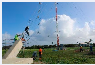
首都から約600km離れたニウアス諸島まで情報伝達を可能にするAMラジオ放送システムのアンテナ建設の様子（写真：JICA）
