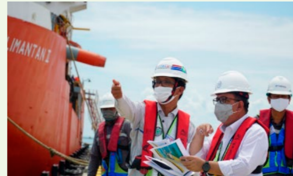
日本の有償資金協力により建設中のインドネシア・パティンバン港開発事業における日本人技術者とインドネシア人技術者による協同作業
