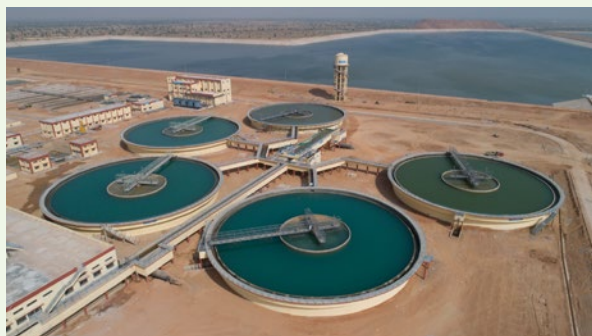
インド北西部のラジャスタン州ナゴール地区で、「ラジャスタン州地方給水・フッ素症対策事業」により建設された浄水場施設。これにより、安全かつ安定的な上水道サービスが確保された。(写真：ラジャスタン州公衆衛生局)
