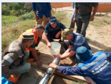
現地の上下水道公社の技術者を対象に、井戸ポンプの維持管理研修を実施するJICA専門家（写真：JICA）
