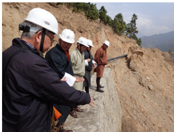
ブータン「道路斜面对策工能力強化プロジェクト」で、植物を植えて道路斜面の浸食や風化を防ぐ工法を現場で実践する専門家（写真：JICA）
