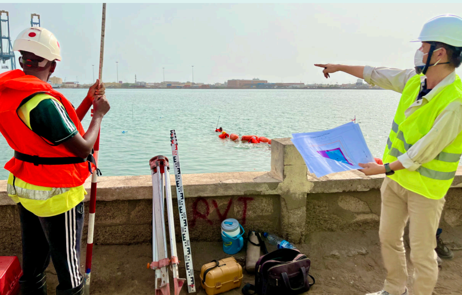
ジブチにおける無償資金協力「タジュラ湾海上輸送能力向上計画」の施工現場にて、現地作業員に指示を出す日本人技術者（写真：JICA）
