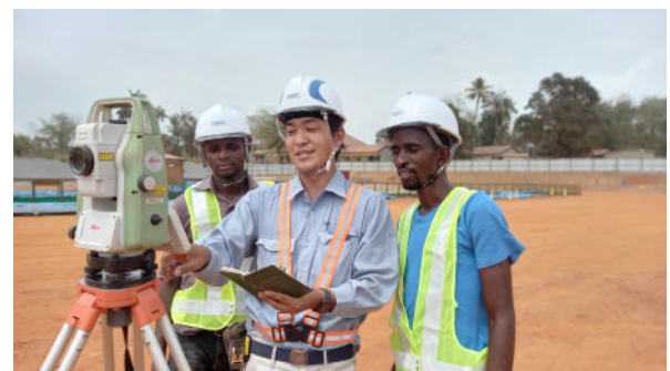
無償資金協力により架け替えが行われているギニアのスンバ橋の工事現場で、日本人専門家が測量方法を教えている様子（写真：大日本土木株式会社）
