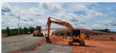
高精度測位データとICT建機を用いた道路工事の様子 (写真: JICA)
