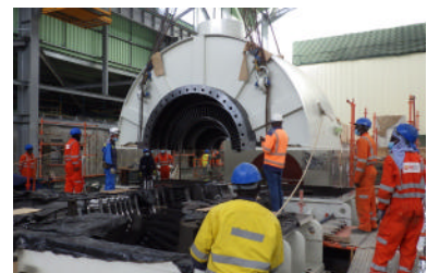
ケニア最大の地熱発電所建設事業を日本の円借款にて支援。発電を支えるタービンの大部分が日本製であり、その納入も日本企業が請け負った。（写真：丸紅（株））
