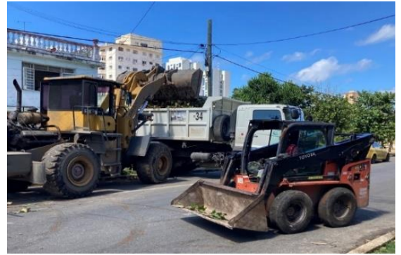
災害廃棄物撤去作業中の ダンプトラックとスキッドステアローダー
