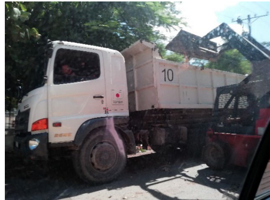
倒木をスキッドステアローダーでダンプトラックに入れる様子
