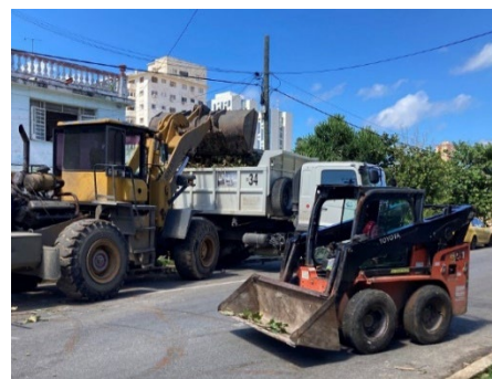
災害廃棄物撤去作業中の ダンプトラックとスキッドステアローダー
