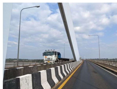
ラオスのサワンナケート(サバナケット)県とタイ国ムクダハンを結ぶ第 2 メコン国際橋
