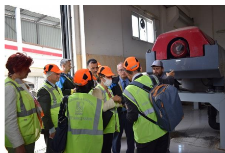
同、汚泥乾燥装置
