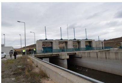
ゲレデ川取水堰(アンカラ給水計画)
