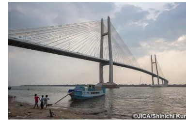
メコン川に架かる橋梁(カンボジア)
