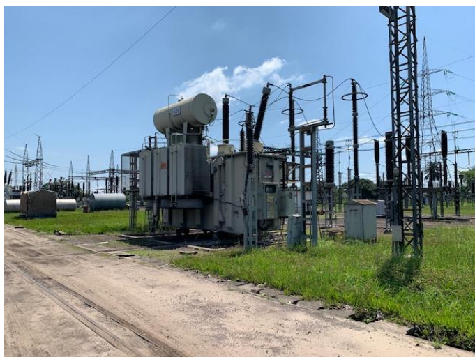
写真1 リミンガ変電所の高/中圧変電器
