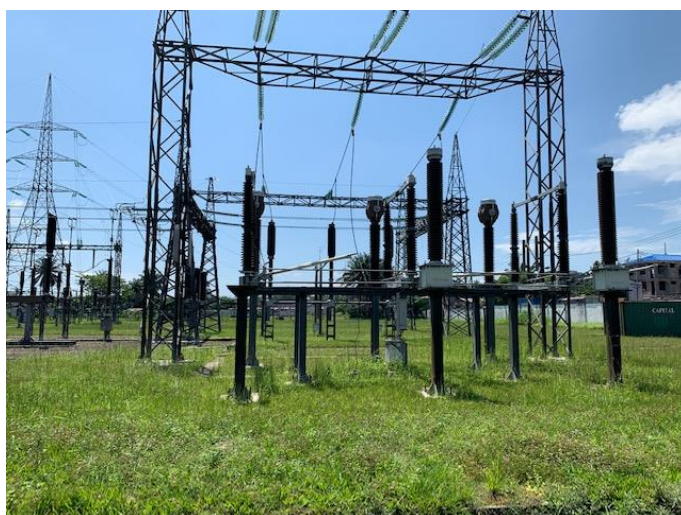
写真2 リミンガ変電所の送電線
