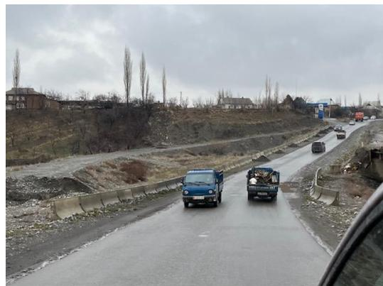
バトケン州 62km 地点。奥に見える道路は損傷・劣化のため封鎖中。現在車が走行中の道路はキルギス政府によって一時的に建設された迂回路。
