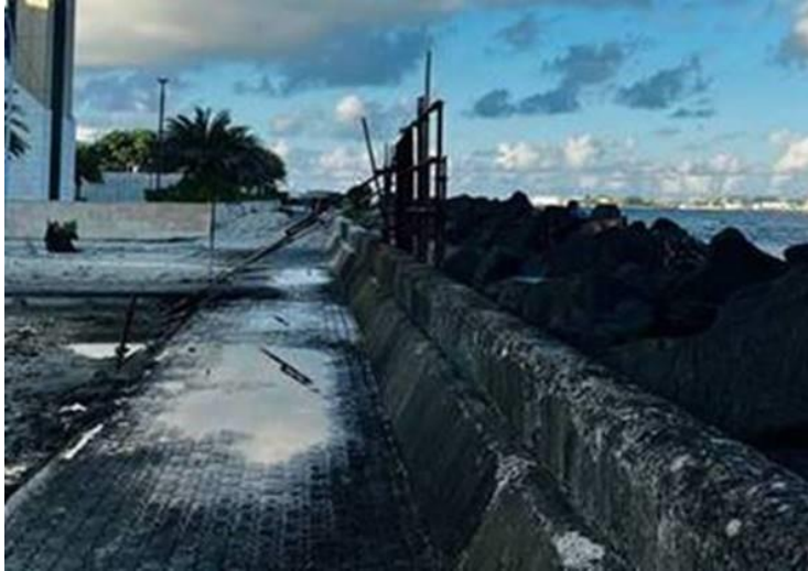
老朽化した防波堤（2021年12月撮影）
