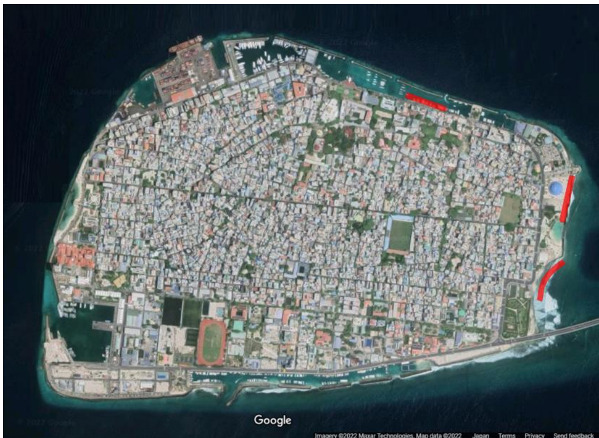
出典：グーグルマップを基に JICA 加工 マレ島全景（赤線が護岸改良箇所）
