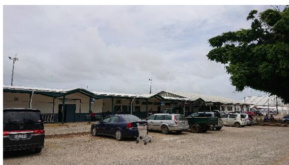
国内線 旅客ターミナル外観
