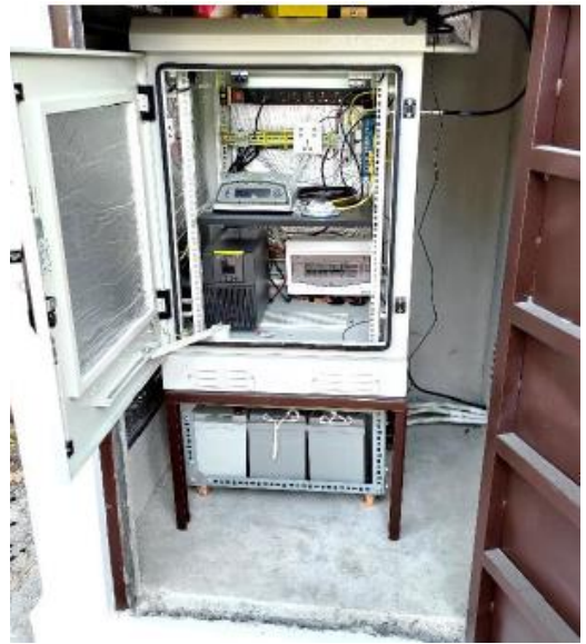
電子基準点内部
