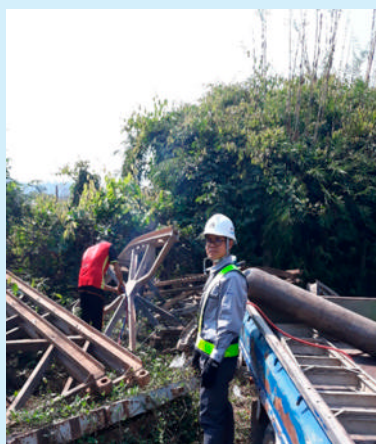
ラオスにて、研究活動の一環として落橋した仮設橋の部材強度の確認作業を行うタボン博士（写真：長崎大学）
