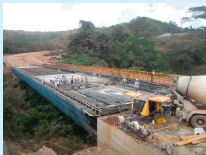
ルスモ国際橋の改修・拡幅工事の様子（写真：JICA）
