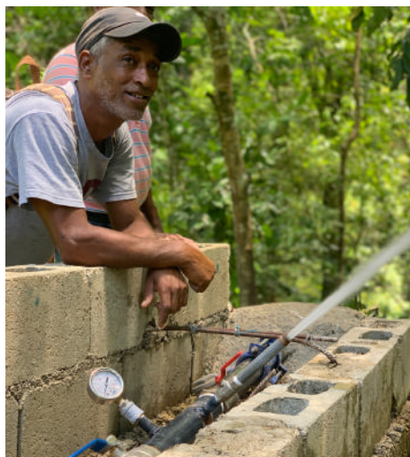
ドミニカ共和国で日本の支援によって完成した上水道の通水状況を確認する様子
